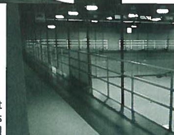
Le remplacement des revêtements de sol
